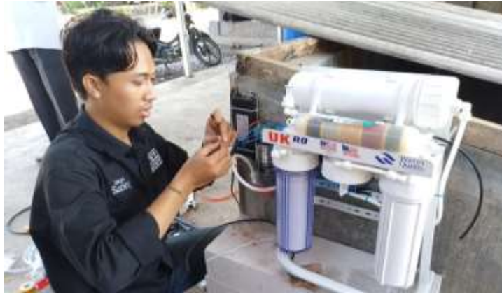
Gambar 6. Perbaikan dan pemeliharaan instalasi ultrafiltrasi reverse osmosis (RO).
