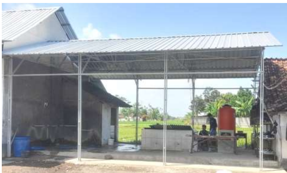
Gambar 5. Fasilitas tempat wudhu dan atap galvalum untuk pelindung sumur artesis serta perbaikan instalasi ultrafiltrasi reverse osmosis (RO).
